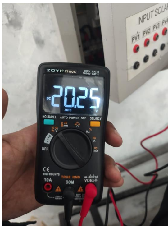
Gambar 10. Pengukuran Output Tegangan PV pada Panel Control
